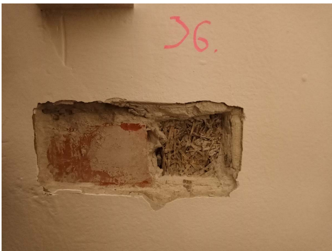
Obrázok č.36 - Sonda č.36 - Obvodové steny nadzemných podlaží sú z nosných stĺpov zo železobetónu a z muriva z keramického materiálu (miestnosť 1.12)
