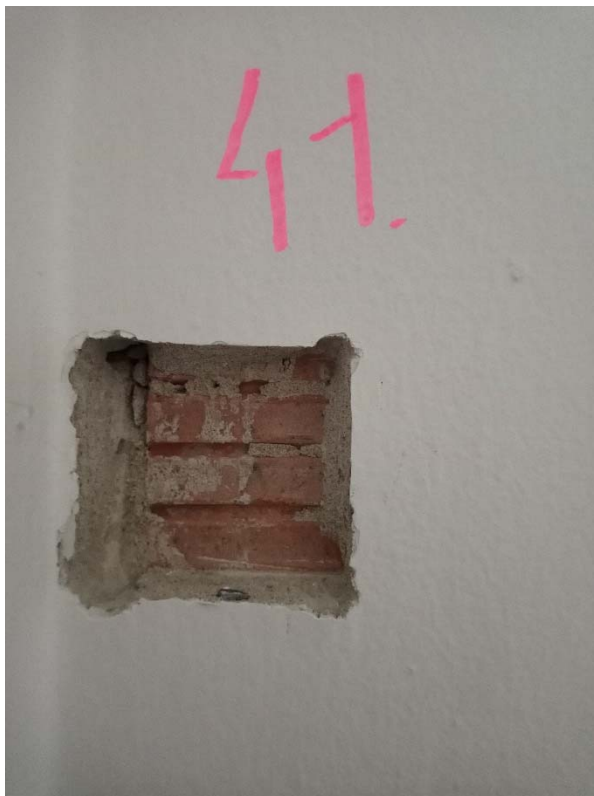
Obrázok č.41 - Sonda č.41 - Obvodové steny nadzemných podlaží sú z nosných stĺpov zo železobetónu a z muriva z keramického materiálu (miestnosť 3.01)
