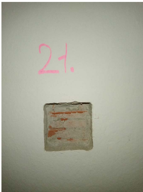
Obrázok č.21 - Sonda č.21 - Obvodové steny nadzemných podlaží sú z nosných stĺpov zo železobetónu a z muriva z keramického materiálu (miestnosť 1.17)
