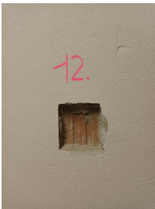
Obrázok č.12 - Sonda č.12 - Materiál steny výťahovej šachty je od 1.NP z keramického materiálu (miestnosť 1.04)
