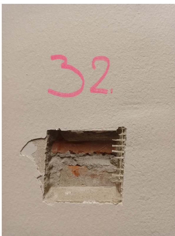
Obrázok č.32 - Sonda č.32 - Obvodové steny nadzemných podlaží sú z nosných stĺpov zo železobetónu a z muriva z keramického materiálu (miestnosť 1.12)
