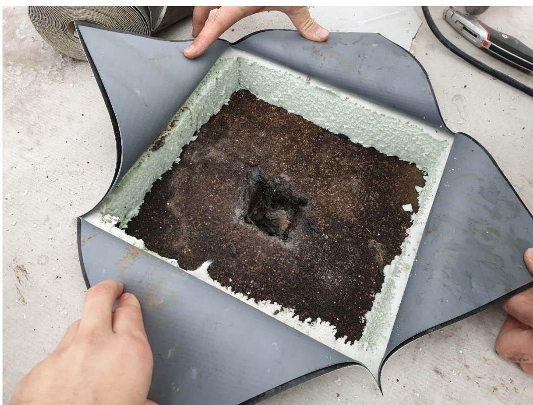
Obrázok č.52 - Sonda č.52 - Preukazuje skladbu strešnej konštrukcie
