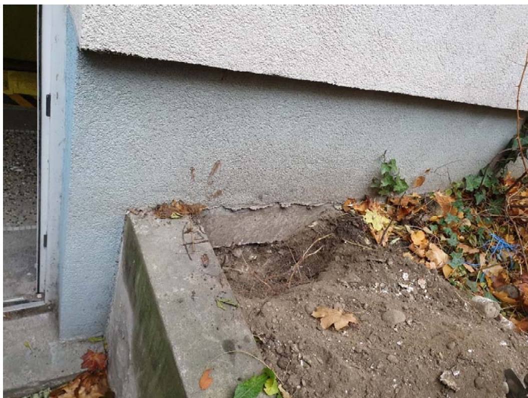
Obrázok č.54 - Sonda č.53 – Materiál obvodovej steny 1.PP je zo železobetónu, obvodová stena je bez hydroizolácie
