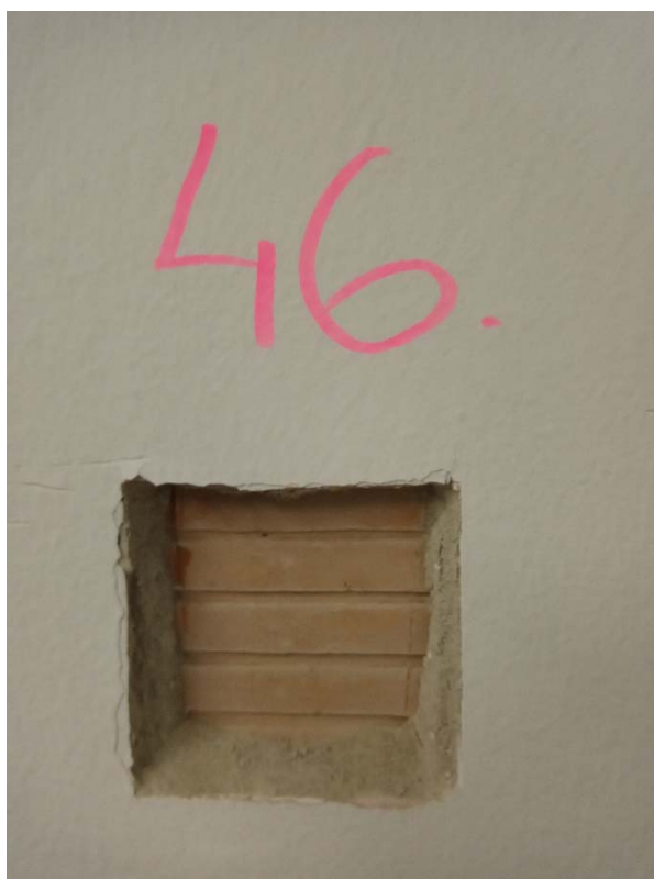
Obrázok č.46 - Sonda č.46 - Obvodové steny nadzemných podlaží sú z nosných stĺpov zo železobetónu a z muriva z keramického materiálu (miestnosť 4.09)
