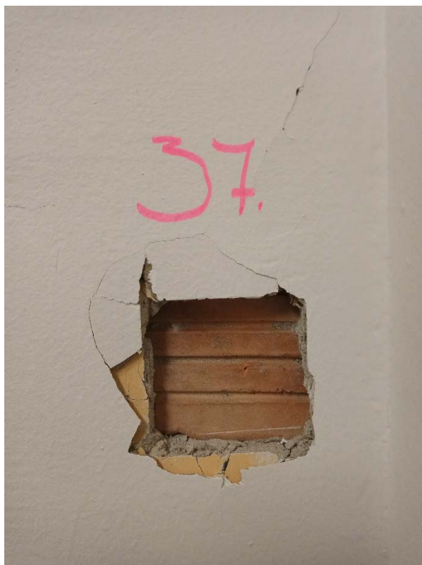
Obrázok č.37 - Sonda č.37 - Obvodové steny nadzemných podlaží sú z nosných stĺpov zo železobetónu a z muriva z keramického materiálu (miestnosť 1.11)
