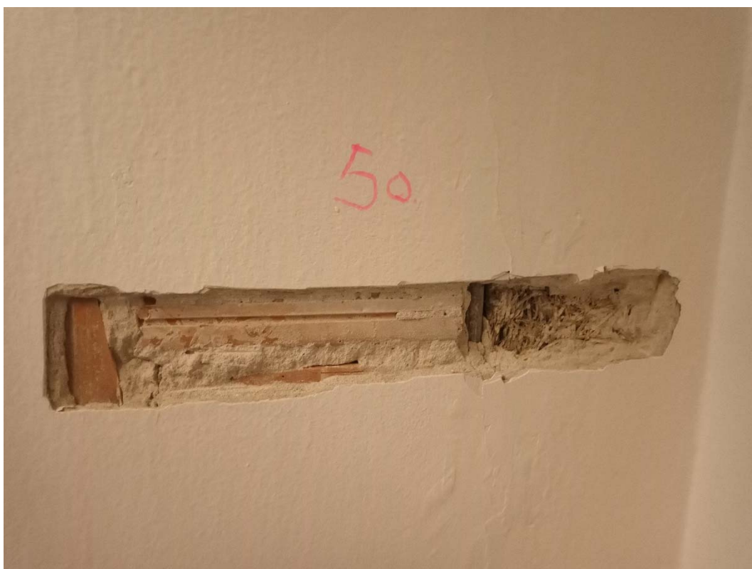
Obrázok č.50 - Sonda č.50 - Obvodové steny nadzemných podlaží sú z nosných stĺpov zo železobetónu a z muriva z keramického materiálu (miestnosť 4.15)
