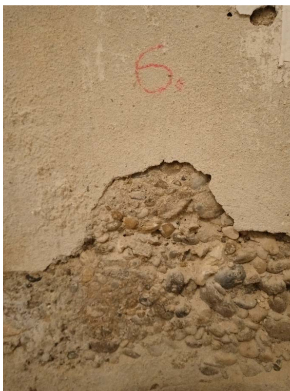
Obrázok č.6 - Sonda č.06 - Materiál obvodovej steny v 1.PP, ktoré sú v kontakte so susedným objektom je železobetón (miestnosť 0.02)
