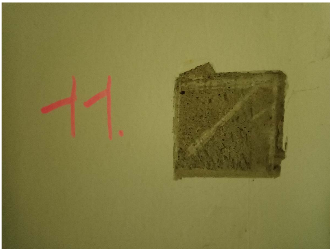
Obrázok č.11 - Sonda č.11 - Materiál vnútorných nosných stĺpov je zo železobetónu, stĺpy sú rôznych rozmerov (miestnosť 0.11)
