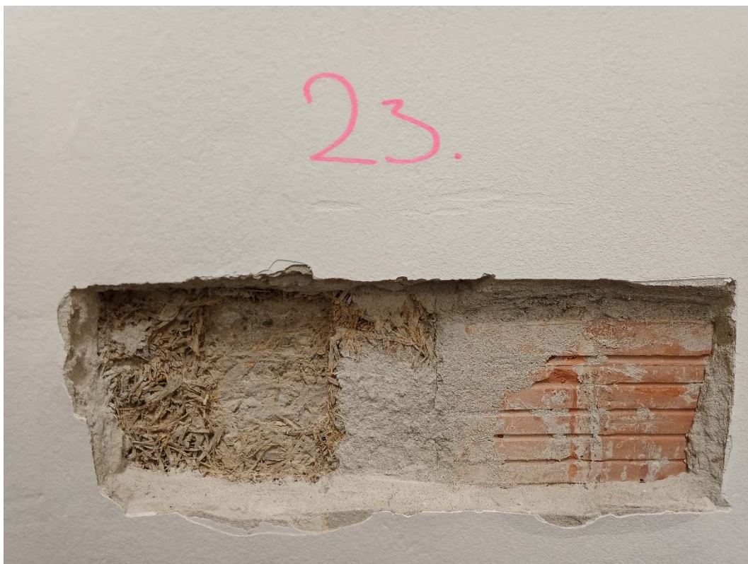
Obrázok č.23 - Sonda č.23 - Obvodové steny nadzemných podlaží sú z nosných stĺpov zo železobetónu a z muriva z keramického materiálu (miestnosť 1.13)
