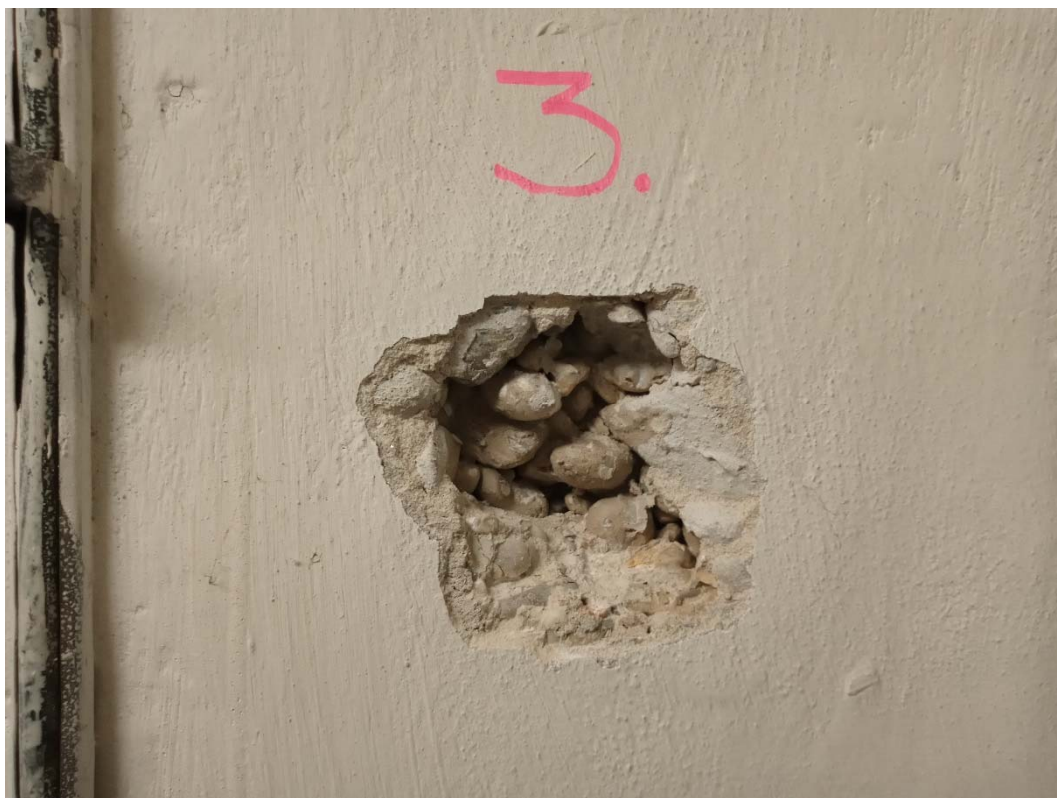
Obrázok č.3 - Sonda č.03 - Materiál steny výťahovej šachty v 1.PP je zo železobetónu (miestnosť 0.03)
