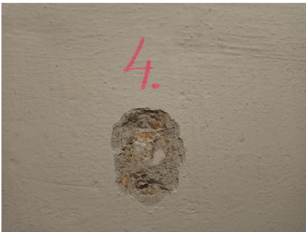
Obrázok č.4 - Sonda č.04 - Materiál steny výťahovej šachty v 1.PP je zo železobetónu (miestnosť 0.03)
