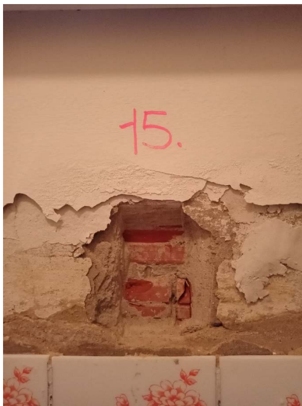
Obrázok č.15 - Sonda č.15 - Obvodové steny nadzemných podlaží sú z nosných stĺpov zo železobetónu a z muriva z keramického materiálu (miestnosť 1.05)
