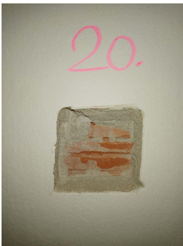
Obrázok č.20 - Sonda č.20 - Obvodové steny nadzemných podlaží sú z nosných stĺpov zo železobetónu a z muriva z keramického materiálu (miestnosť 1.17)
