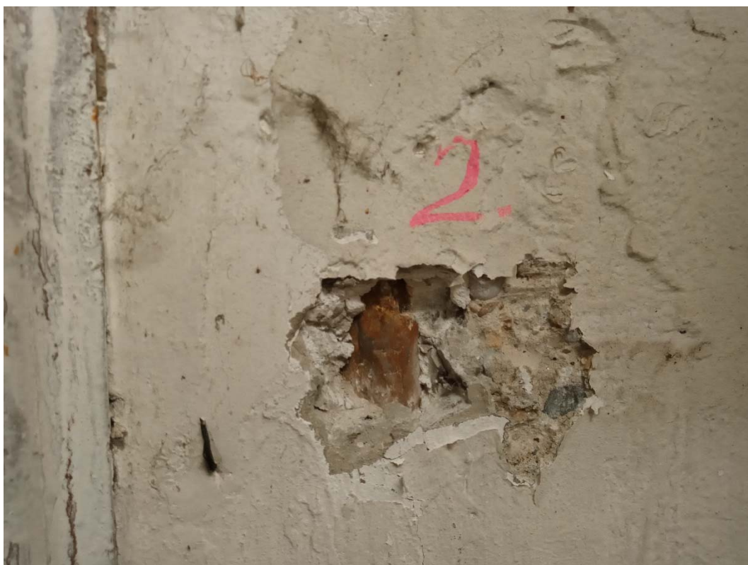
Obrázok č.2 - Sonda č.02 - Materiál obvodovej steny v 1.PP je zo železobetónu (miestnosť 0.03)
