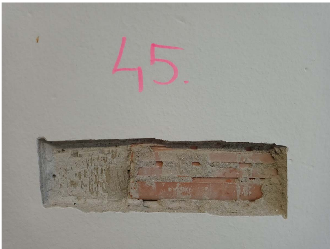
Obrázok č.45 - Sonda č.42 - Obvodové steny nadzemných podlaží sú z nosných stĺpov zo železobetónu a z muriva z keramického materiálu (miestnosť 4.09)
