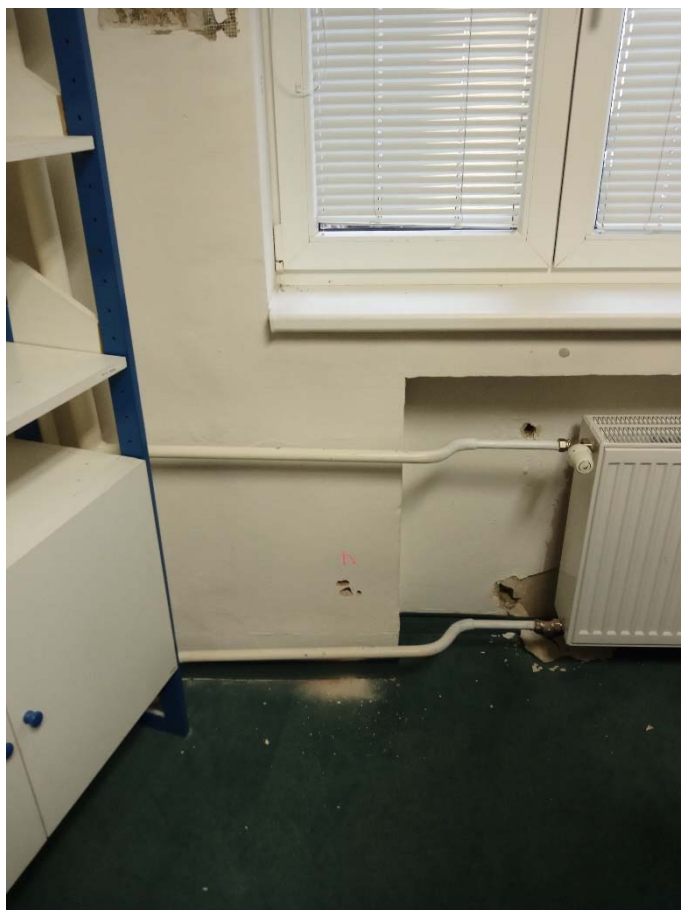
Obrázok č.59 - Sonda D - Vŕtaná sonda na zistenie vlhkosti v konštrukcii (miestnosť 1.07)
