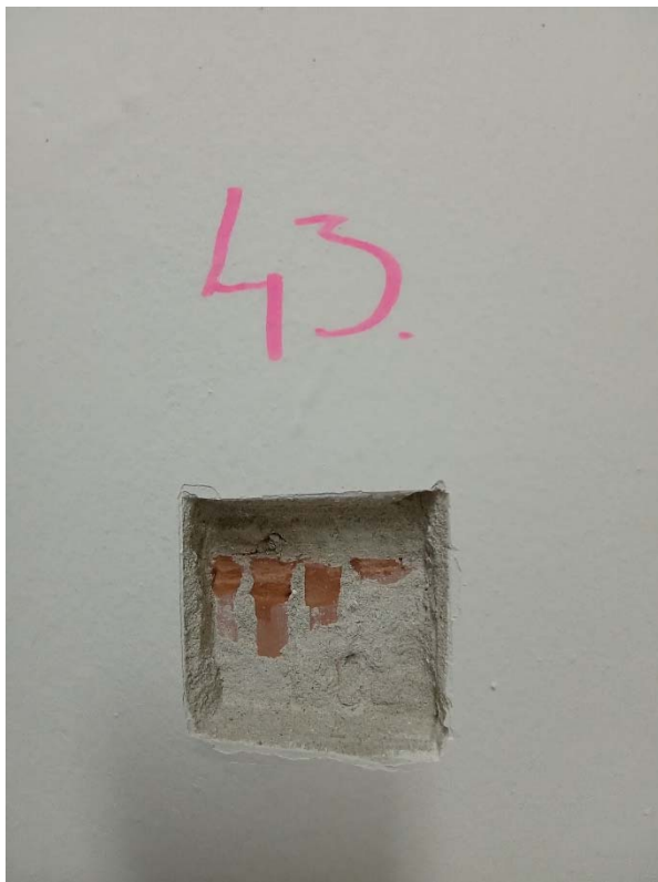
Obrázok č.43 - Sonda č.43 - Materiál steny výťahovej šachty je od 1.NP z keramického materiálu (miestnosť 4.03)
