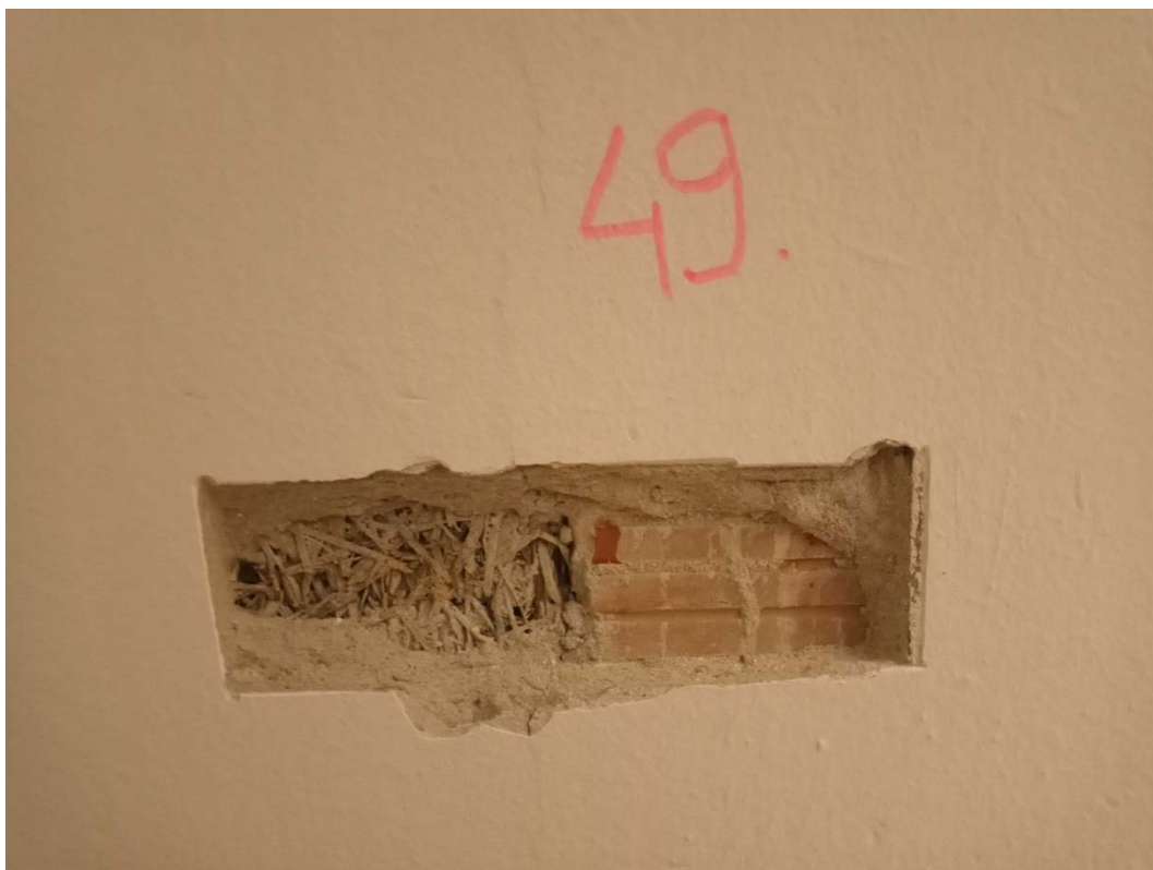
Obrázok č.49 - Sonda č.49 - Obvodové steny nadzemných podlaží sú z nosných stĺpov zo železobetónu a z muriva z keramického materiálu (miestnosť 4.15)
