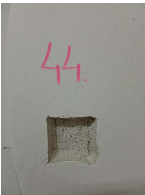
Obrázok č.44 - Sonda č.44 - Obvodové steny nadzemných podlaží sú z nosných stĺpov zo železobetónu a z muriva z keramického materiálu (miestnosť 4.03)
