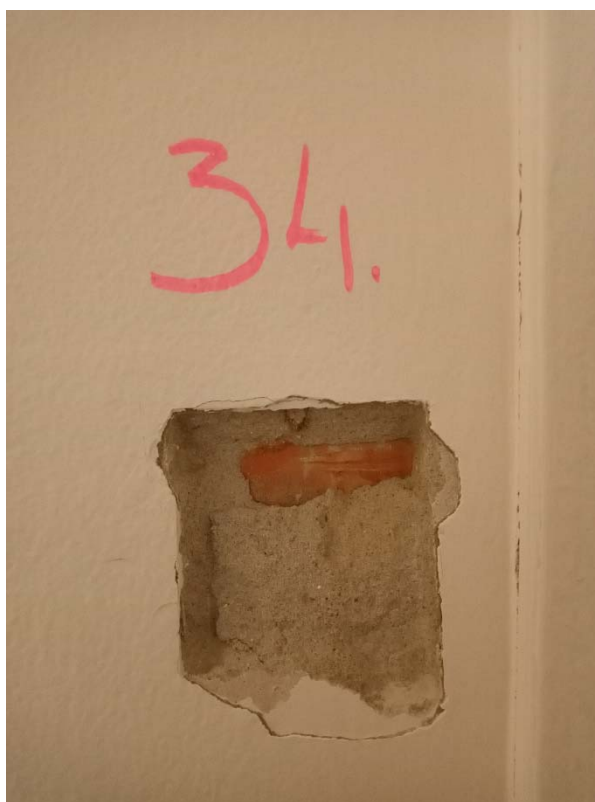
Obrázok č.34 - Sonda č.34 - Obvodové steny nadzemných podlaží sú z nosných stĺpov zo železobetónu a z muriva z keramického materiálu (miestnosť 1.12)
