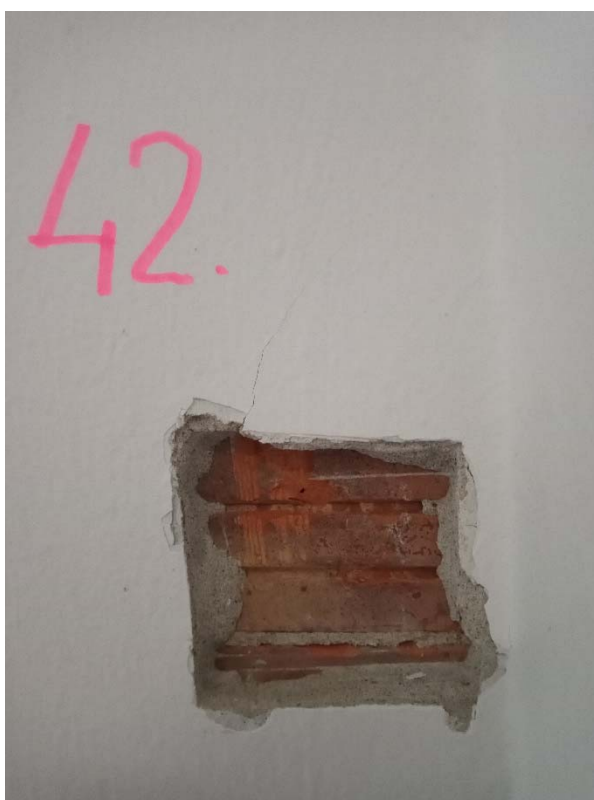
Obrázok č.42 - Sonda č.42 - Obvodové steny nadzemných podlaží sú z nosných stĺpov zo železobetónu a z muriva z keramického materiálu (miestnosť 3.01)
