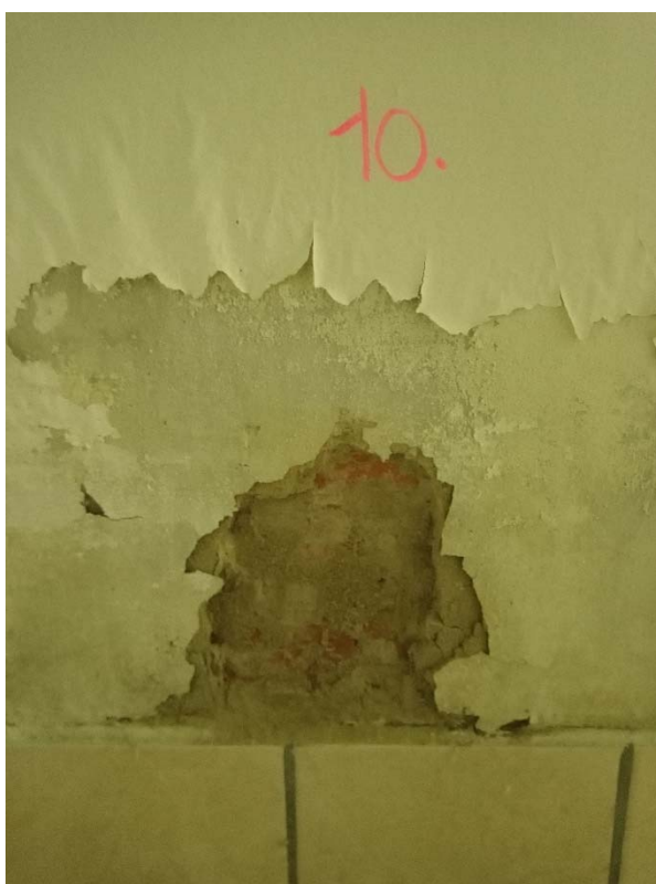
Obrázok č.10 - Sonda č.10 - Materiál vnútorných priečok je z keramického materiálu hrúbky 100 mm (miestnosť 0.11)
