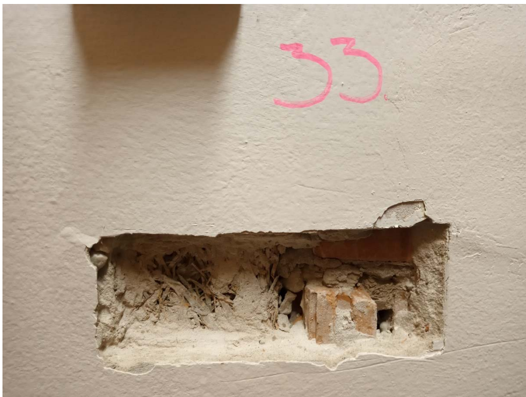
Obrázok č.33 - Sonda č.33 - Obvodové steny nadzemných podlaží sú z nosných stĺpov zo železobetónu a z muriva z keramického materiálu (miestnosť 1.12)
