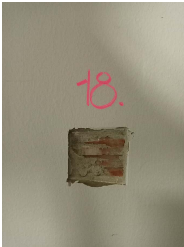
Obrázok č.18 - Sonda č.18 - Obvodové steny nadzemných podlaží sú z nosných stĺpov zo železobetónu a z muriva z keramického materiálu (miestnosť 1.07)
