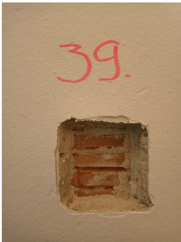
Obrázok č.39 - Sonda č.39 - Obvodové steny nadzemných podlaží sú z nosných stĺpov zo železobetónu a z muriva z keramického materiálu (miestnosť 1.10)
