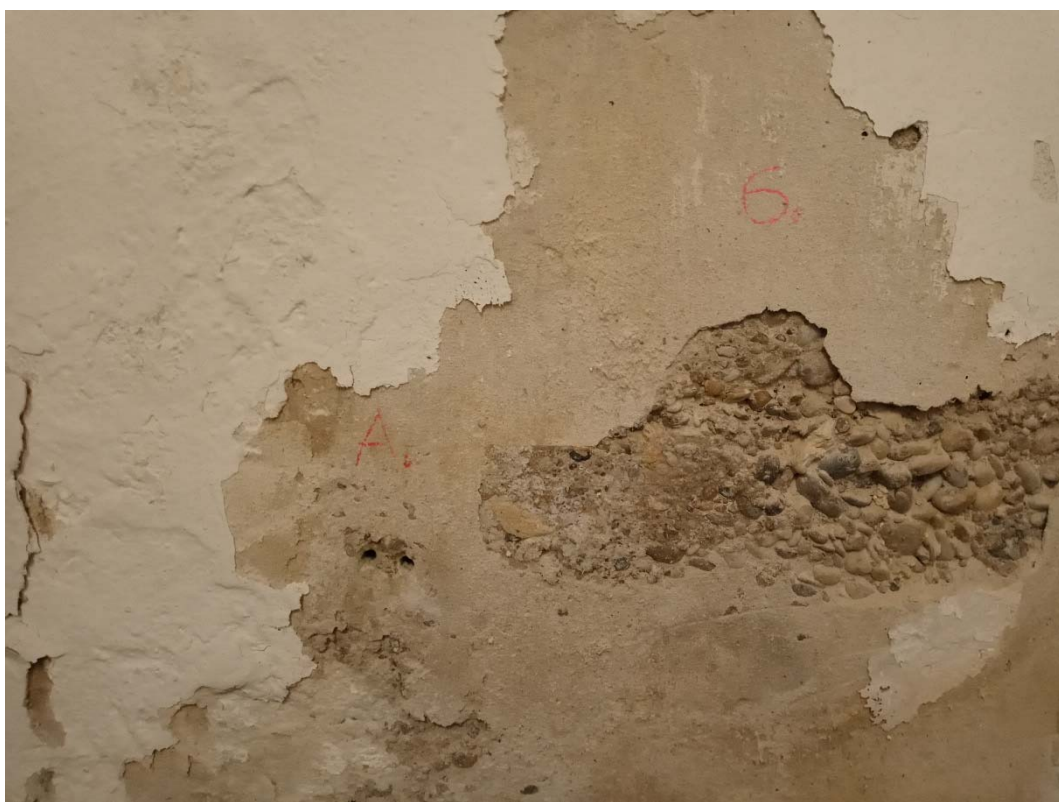
Obrázok č.56 - Sonda A - Vŕtaná sonda na zistenie vlhkosti v konštrukcii (miestnosť 0.02)
