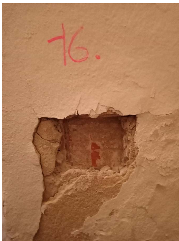
Obrázok č.16 - Sonda č.16 - Materiál vnútorných priečok je z keramického materiálu hrúbky 100 mm (miestnosť 1.05)
