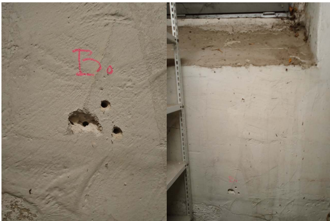
Obrázok č.57 - Sonda B - Vŕtaná sonda na zistenie vlhkosti v konštrukcii (miestnosť 0.03)
