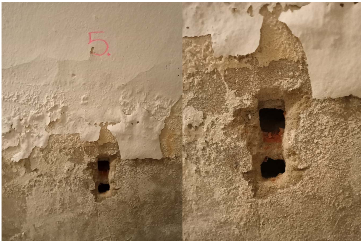
Obrázok č.5 - Sonda č.05 - Materiál vnútorných priechok je z keramického materiálu hrúbky 100 mm (miestnosť 0.02)
