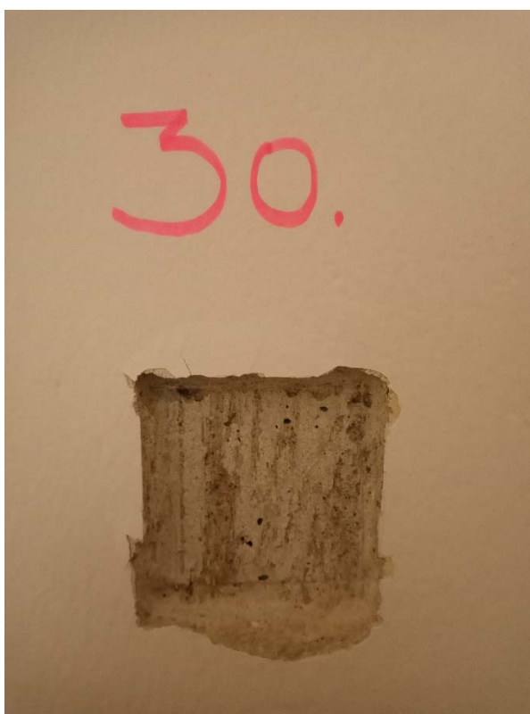
Obrázok č.30 - Sonda č.30 - Materiál vnútorných nosných stĺpov je zo železobetónu, stĺpy sú rôznych rozmerov (miestnosť 1.12)
