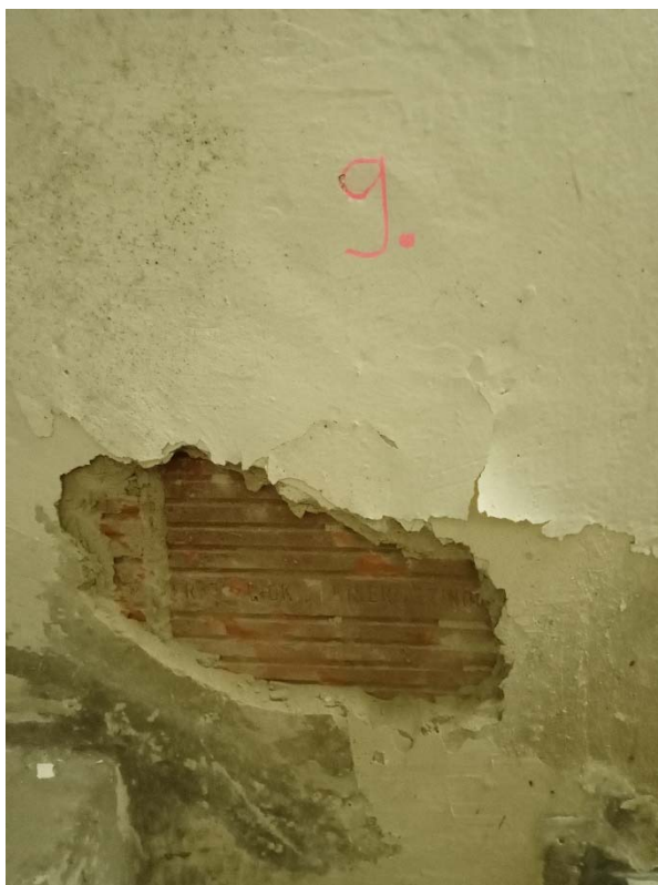
Obrázok č.9 - Sonda č.09 - Materiál vnútorných priečok je z keramického materiálu hrúbky 100 mm (miestnosť 0.01)
