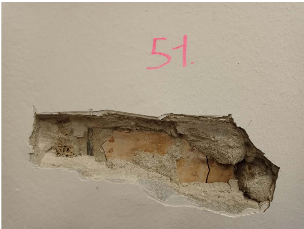
Obrázok č.51 - Sonda č.51 - Obvodové steny nadzemných podlaží sú z nosných stĺpov zo železobetónu a z muriva z keramického materiálu (miestnosť 4.14)
