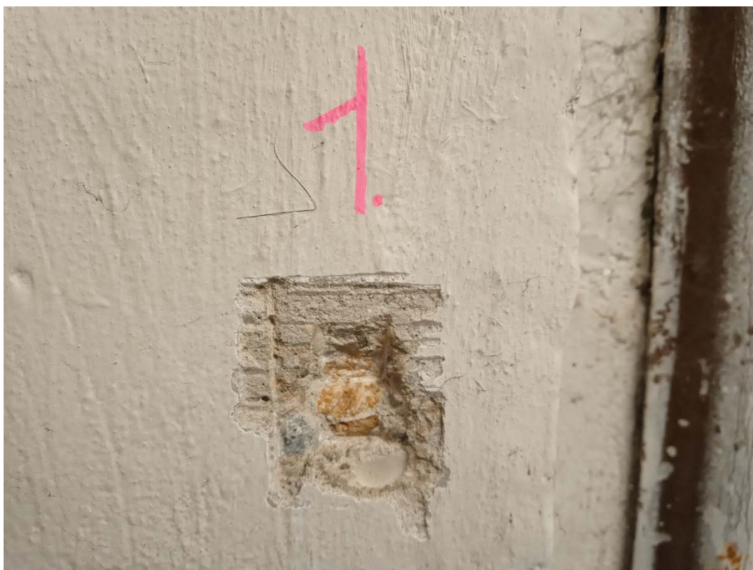
Obrázok č.1 - Sonda č.01 - Materiál obvodovej steny v 1.PP je zo železobetónu (miestnosť 0.03)
