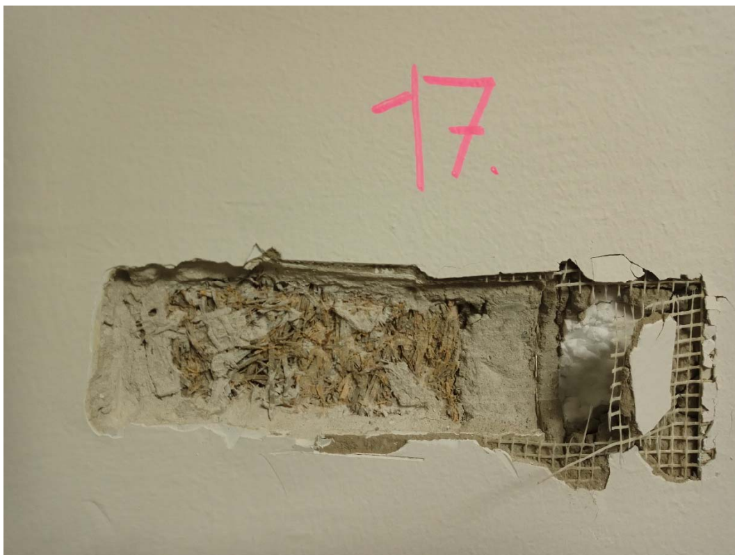
Obrázok č.17 - Sonda č.17 - Obvodové steny nadzemných podlaží sú z nosných stĺpov zo železobetónu a z muriva z keramického materiálu, ostenia okenných otvorov sú vyrovnávané pomocou polystyrénu (miestnosť 1.07)
