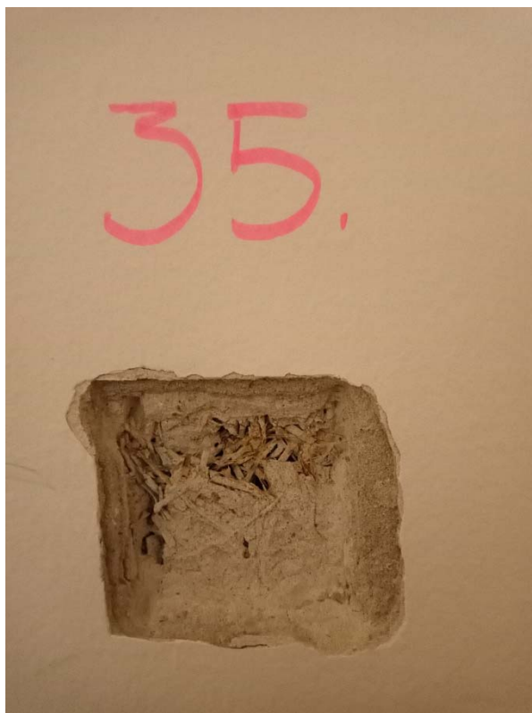
Obrázok č.35 - Sonda č.35 - Obvodové steny nadzemných podlaží sú z nosných stĺpov zo železobetónu a z muriva z keramických tvárnic (miestnosť 1.12)
