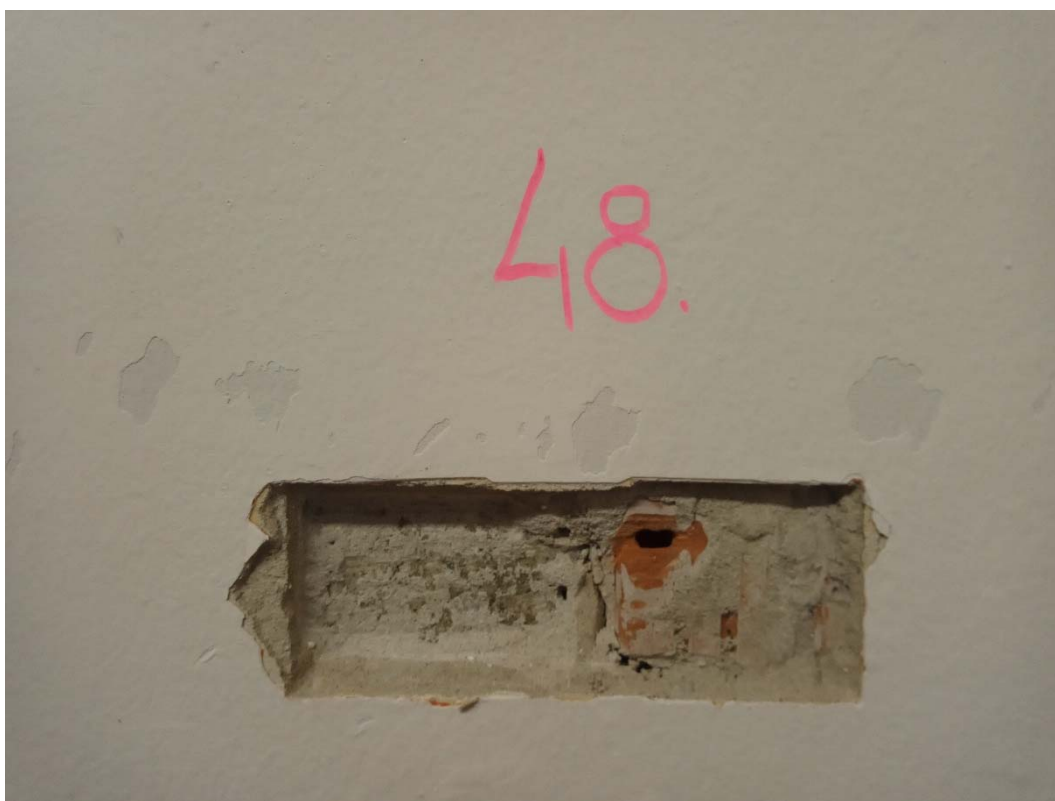
Obrázok č.48 - Sonda č.48 - Obvodové steny arkiera sú z keramického materiálu (miestnosť 4.16)
