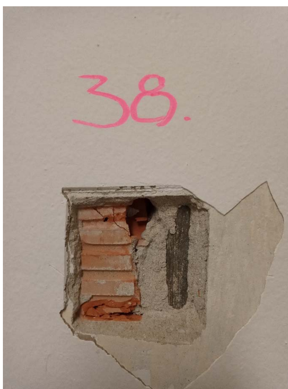
Obrázok č.38 - Sonda č.38 - Obvodové steny nadzemných podlaží sú z nosných stĺpov zo železobetónu a z muriva z keramického materiálu (miestnosť 1.09)
