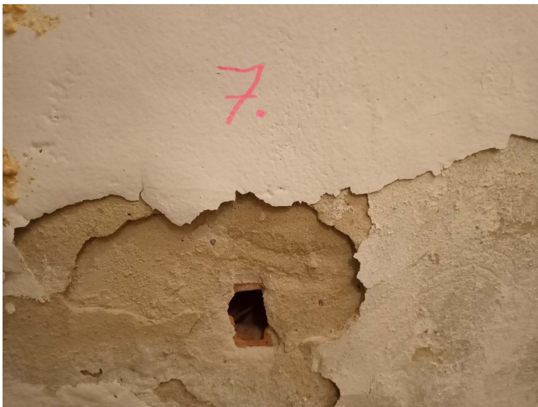
Obrázok č.7 - Sonda č.07 - Materiál vnútorných priečok je z keramického materiálu hrúbky 100 mm (miestnosť 0.02)
