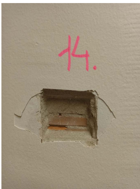
Obrázok č.14 - Sonda č.14 - Obvodové steny nadzemných podlaží sú z nosných stĺpov zo železobetónu a z muriva z keramického materiálu (miestnosť 1.04)
